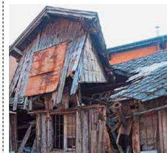
Schon fast ganz zerfallen: Dieses Häuschen beim Tiergarten in Mels. Bild: Andrea Keller
